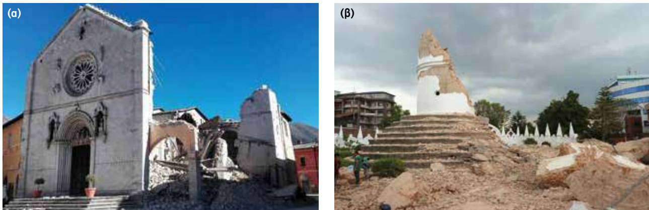
Εικ. 4 (α) Ο ναός του Αγίου Βενέδικτου στη πόλη Norcia στην Κεντρική Ιταλία μετά το σεισμό της 30ης Οκτωβρίου 2016 με μέγεθος M_w = 6.5 (Φωτογραφία από Καθηγητή Δρ. Ευθύμη Λέκκα, Norcia 2016) (β) Το Dhara-hara, επίσης γνωστό ως Πύργος Bhimsen, ένας εννιάοροφος πύργος κατασκευασμένος το 1834 καταστράφηκε ολοσχερώς κατά τη διάρκεια του καταστροφικού σεισμού του Νεπάλ στις 25 Απριλίου 2015 με μέγεθος M_w = 7.8 . (Φωτογραφία από Καθηγητή Δρ. Ευθύμη Λέκκα, Νεπάλ 2015) Πηγή: Παραδοτέο Δράσης Β - «BeSafeNet - Protect yourself from hazards»
