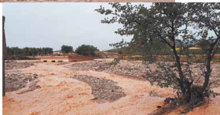
Θαμμένη κατοικία από φερτά υλικά κατά τη διάρκεια Ξαφνικής πλημμύρας (flash flood) στην περιοχή της Αττικής
